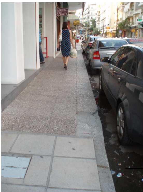
ΟΔΟΣ Λ.ΠΑΠΑΠΑΥΛΟΥ, ΚΑΚΟΤΕΧΝΙΑ ΣΕ ΠΕΖΟΔΡΟΜΙΟ, ΑΝΟΜΟΙΟΜΟΡΦΙΑ ΠΛΑΚΩΝ ΠΕΖΟΔΡΟΜΙΟΥ, ΙΔΙΩΤΙΚΗ ΠΑΡΕΜΒΑΣΗ ΣΕ ΔΗΜΟΣΙΟ ΧΩΡΟ (Α05)
